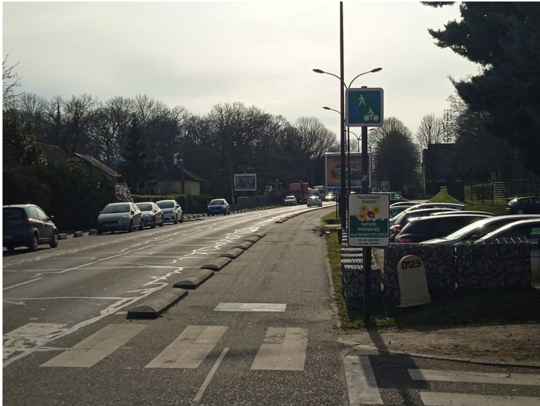
On voit ici la ligne médiane de la piste cyclable effacée.
